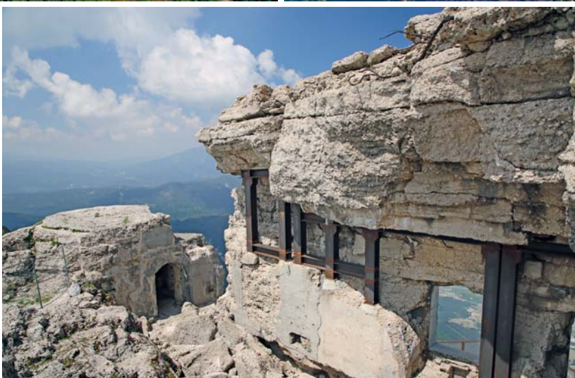
Ruine einer österreichischen Befestigungsanlage auf der Cima Vezzena
