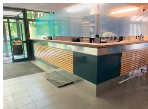
Renovierungsarbeiten: Anbau der Plexiglasscheibe am Tresen zum Schutz von Gästen und Personal, Verschrottung der alten Leuchten und viel frische Farbe machen den Unterschied
